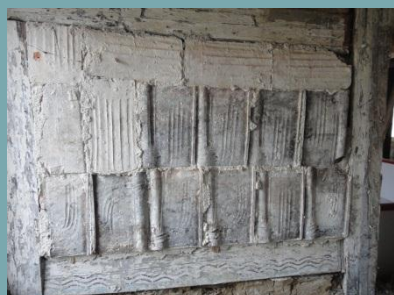
Historische handgestrichene Ziegel als Innenwandverkleidung
