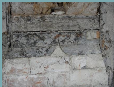
Ein interessanter Kielbogensturz im Obergeschoss, aus dem Jahre 1474.
