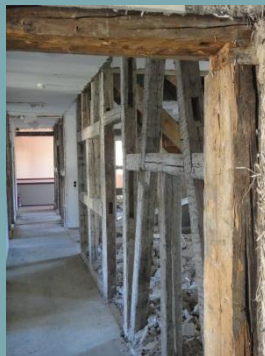
Während der Entkernung, im Oktober 2014
