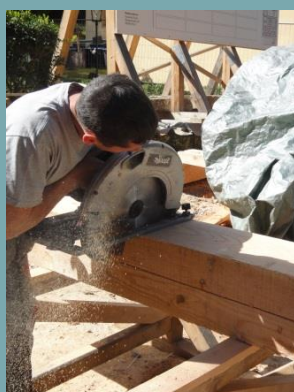
Hier ist maßgenaue Arbeit notwendig - Zuschnitt
