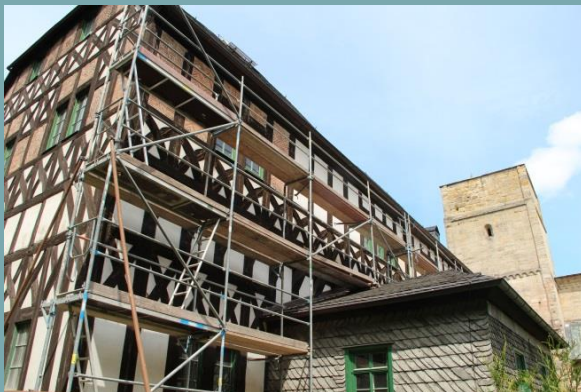
Gerüstaufbau an der Ostseite der Klosterruine
