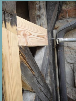
Saniertes Fachwerkelement an der Ostfassade
