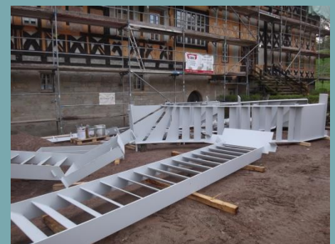
Treppeneinzelteile warten auf den Einbau
