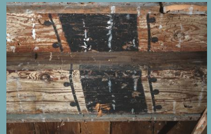
Verzierte Deckenbalken um 1474
